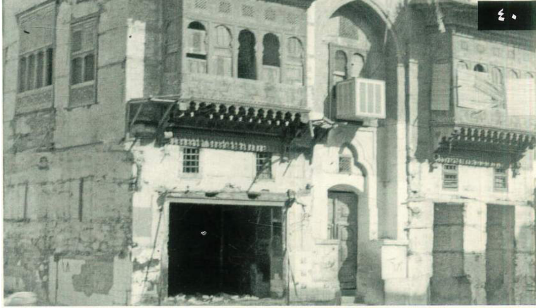
لوحة (23) توضح بيت القلعي وسماكة الجدران فيه وقواعد الرواشين والذي يقع في حارة القشاشية عام 1397هـ نقلا عن أنيس شودري، لقطات من المعالم العمرانية لمكة المكرمة والمدينة المنورة والطائف "1387 - 1404هـ"
